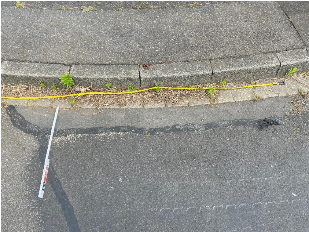
Bild 2: Reparaturstelle mit Bitumennähten und Reifenabdruck Landwirtschaft
