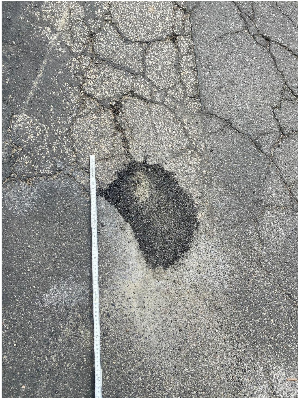
Bild 4: Kaltasphalt Sanierung angrenzend
