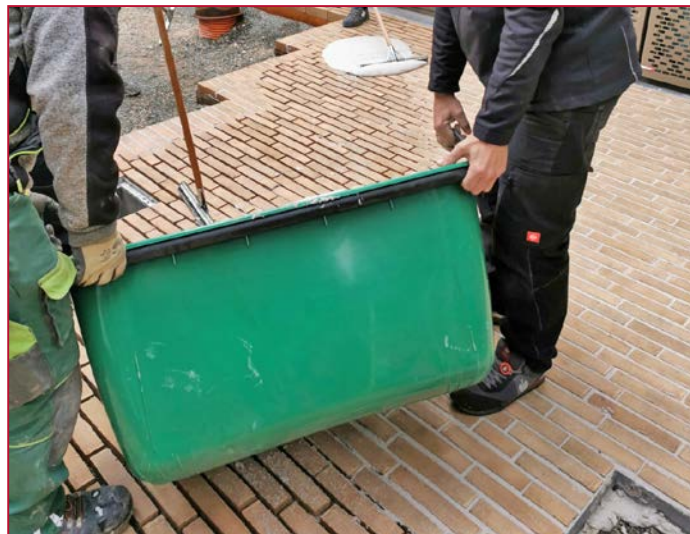
Einbringen von ROMPOX® - D1 neutral mit effizientem Verteilsystem.
