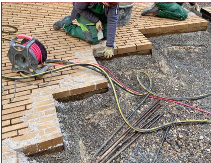
Präzise Klinkerverlegung auf vorbereiteter Tragschicht.
