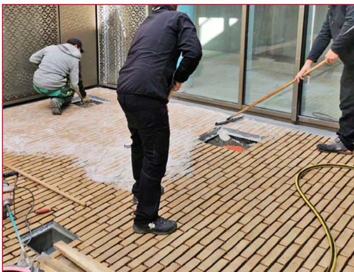
Verarbeiten des Fugenmörtels nach der Einweisung durch ROMEX®-Techniker vor Ort.
