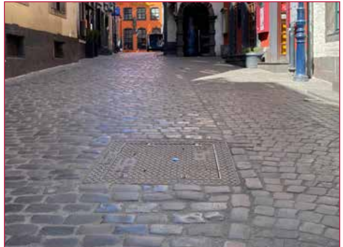
Result after jointing with ROMPOX® - D2000 Résultat après le jointoiement avec ROMPOX® - D2000
