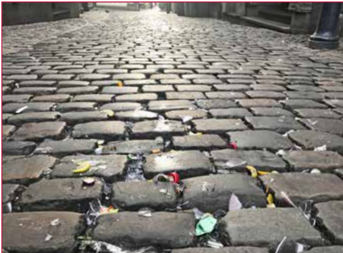
Before: Garbage and dangerous shards in the joints Avant: déchets et tessons dangereux dans les joints
