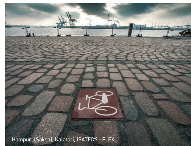
Borkum, Wandelbahn (Saksa), ROMPOX® - D2000
