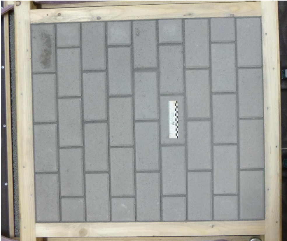
Bild 5: Herstellung der Pflasterdecke
