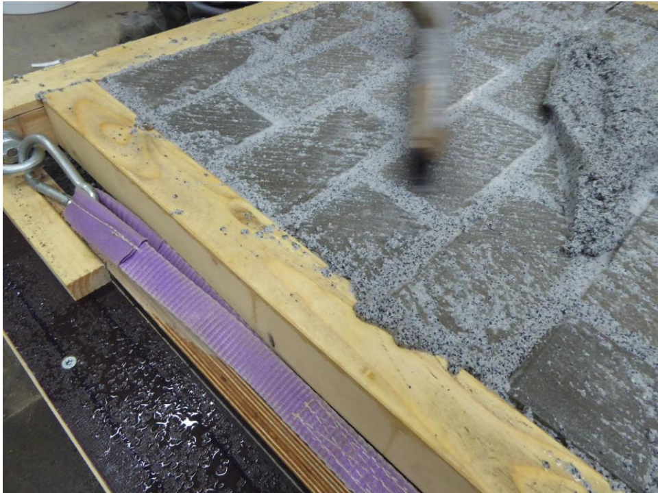
Bild 9: Einbringung des Fugenmörtels
