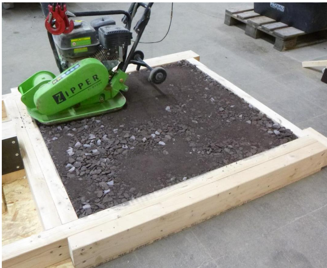
Bild 2: Verdichtung der Tragschicht
