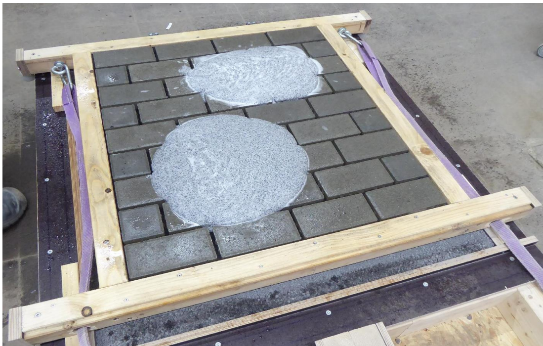
Bild 8: Einbringung des zähelastischen Fugenmörtels
