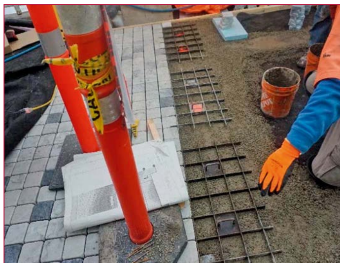
Pose précise des pavés à l'aide d'un guide
