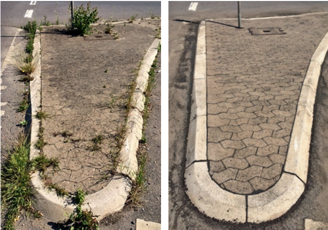
Euskirchen, Tyskland, ROMPOX® - FUGENSAND NP + ROMPOX® - D7000
