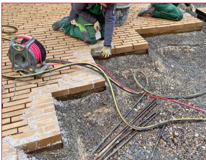
Pose précise des clinker sur une couche de support préparée
