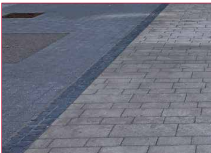
Nahaufnahme der Fugen (Der Kunstharzfilm ist bereits größtenteils abgewittert)
