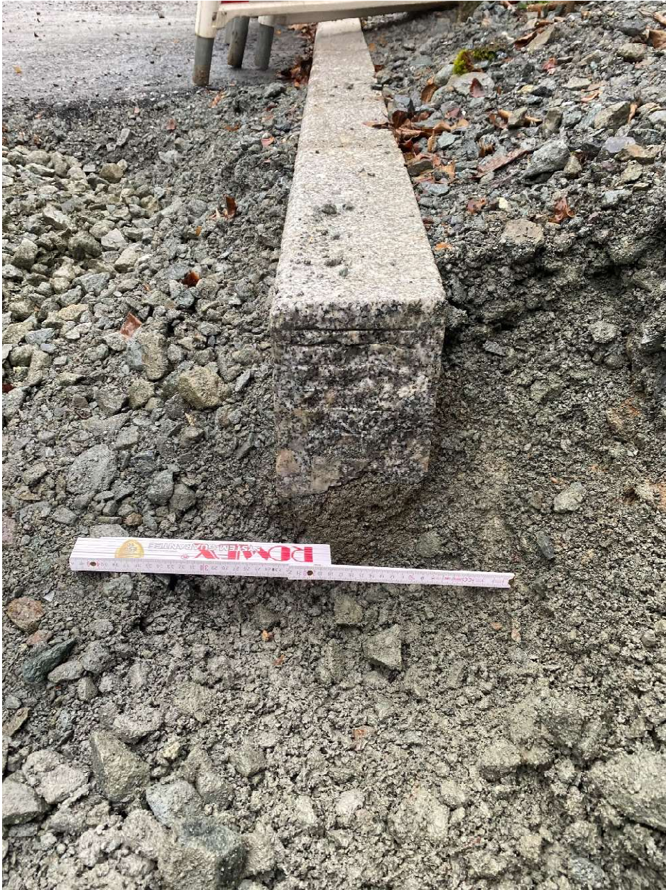
Bild 6: Dimensionierung Fundamentierung
