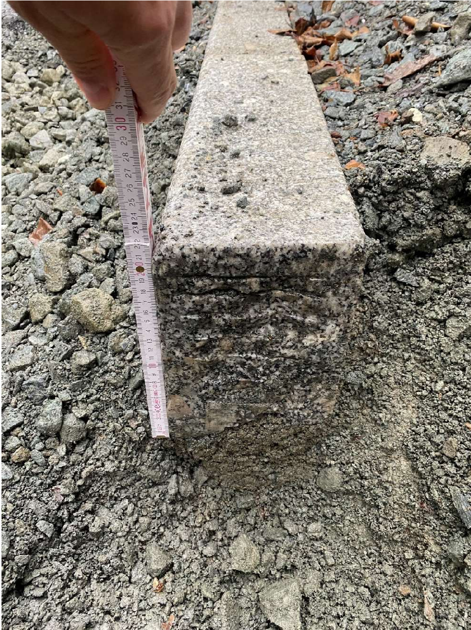
Bild 5: Dimensionierung Borde aus Granit
