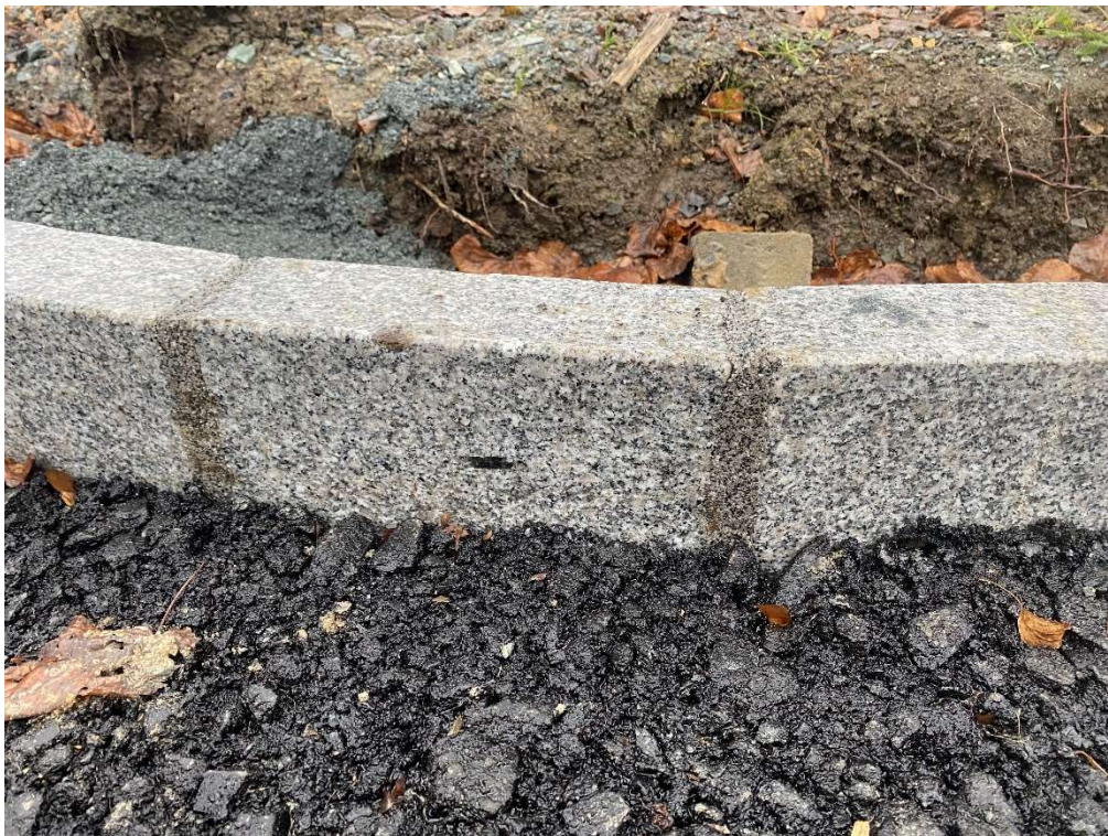
Bild 10: Fugenschluss im Kurvenbereich
