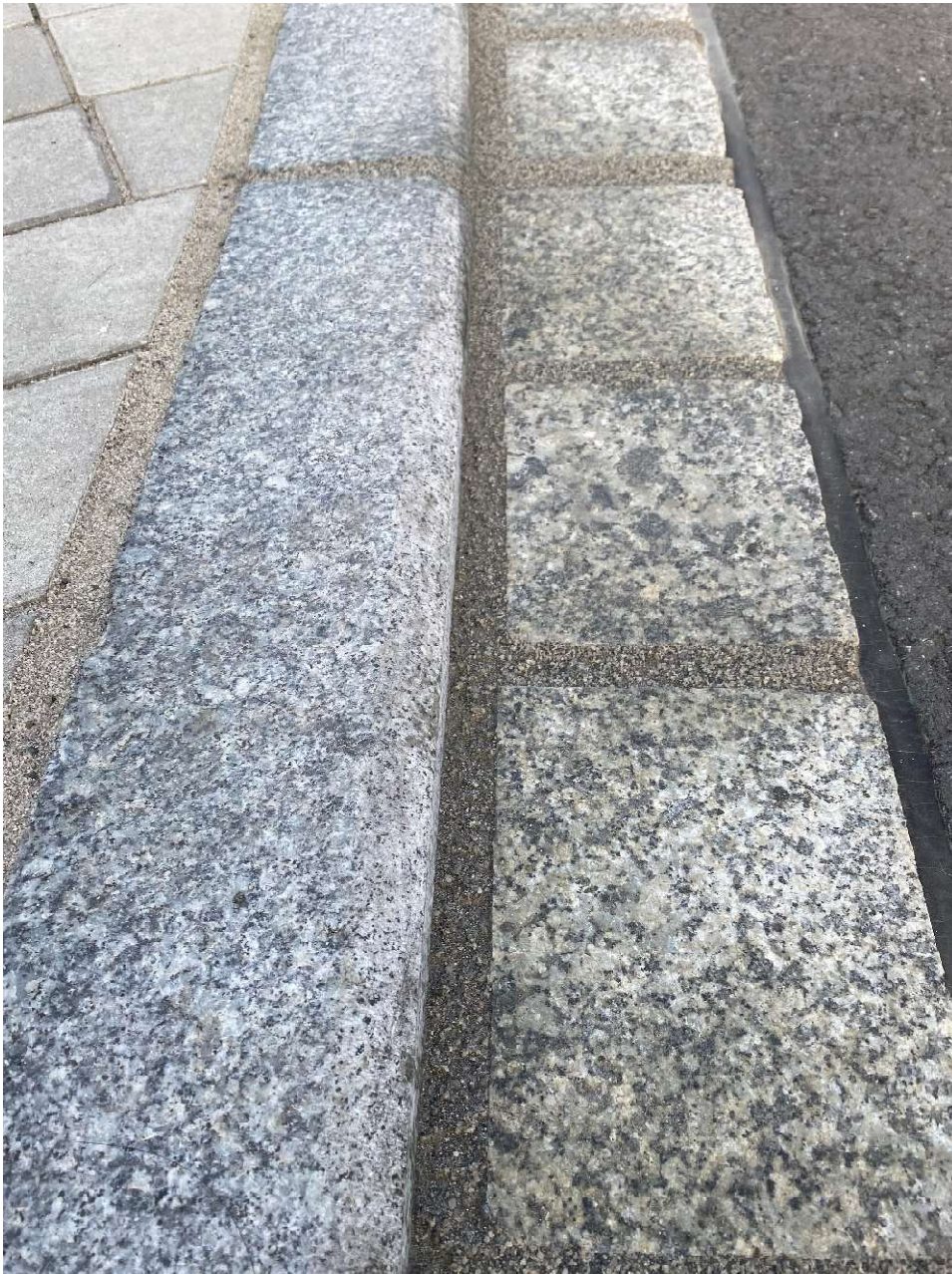
Bild 4: Detail Rinne mit Übergang zum Asphalt
