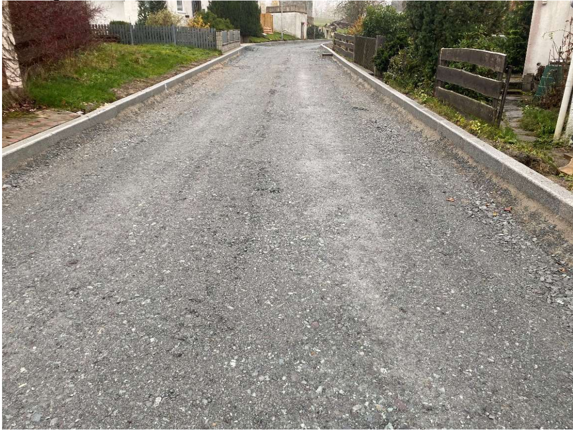
Bild 8: Planum der Tragschicht
