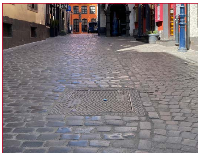
Résultat après jointoiement avec ROMPOX® - D2000
