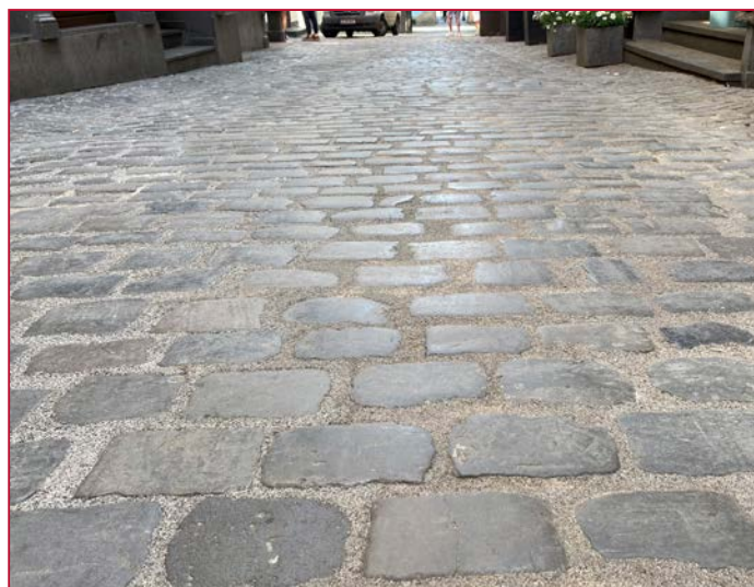
Après: antidérapant et résistant au nettoyage haute pression
