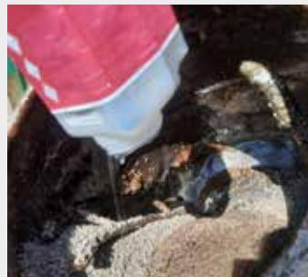
Anschließend wurden mit den Produkten ROMPOX®- 201 DEKO UV und ROMPOX®- 202 DEKO EP auf allen Aufbauten Längsstreifen fachgerecht aufgebracht. Das Produkt ROMPOX®- 201 DEKO UV wurde mit zwei weißen Marmorsplitten a) 4/7 mm und b) 2/4 mm mit je 5% Bindemittelanteil, ROMPOX®- 202 DEKO EP mit braunem Granitsplitt 3/5 mm und 6% Bindemittelanteil verarbeitet.
