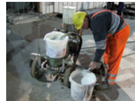
Beispiel eines Kolben-Airlessgeräts im Einsatz
