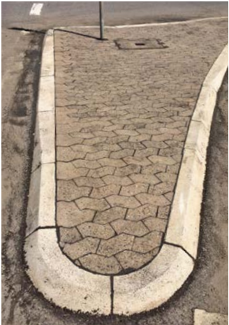
Euskirchen Zülrich (Németország), ROMPOX® - FUGENSAND NP + ROMPOX® - D7000
