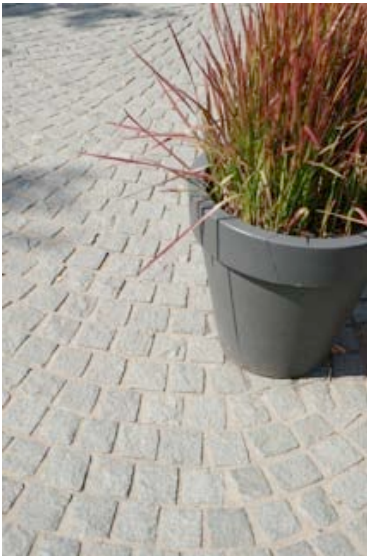
Abbildung: Segmentbögen mit Verfugung D 2000
