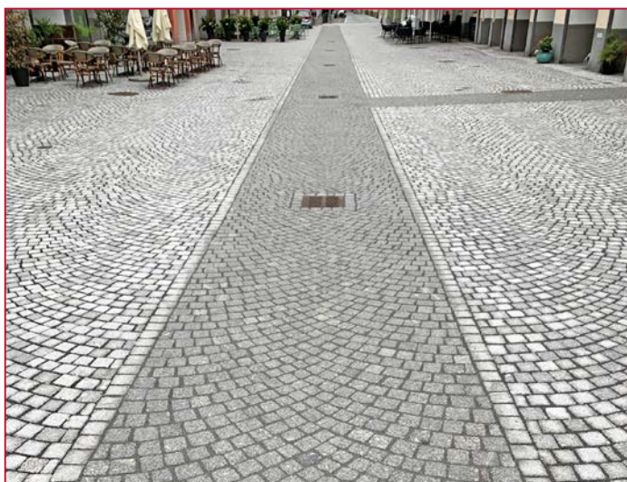
Jointoiment propre
