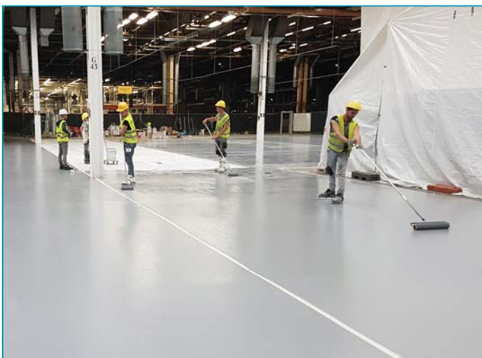
Verarbeitung der ROMPOX® Produkte | Application of ROMPOX® products
